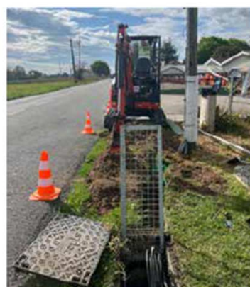
Raccordement pleine terre : la Direction Numérique réalise des travaux en interne pour résoudre la situation, Doazit.
